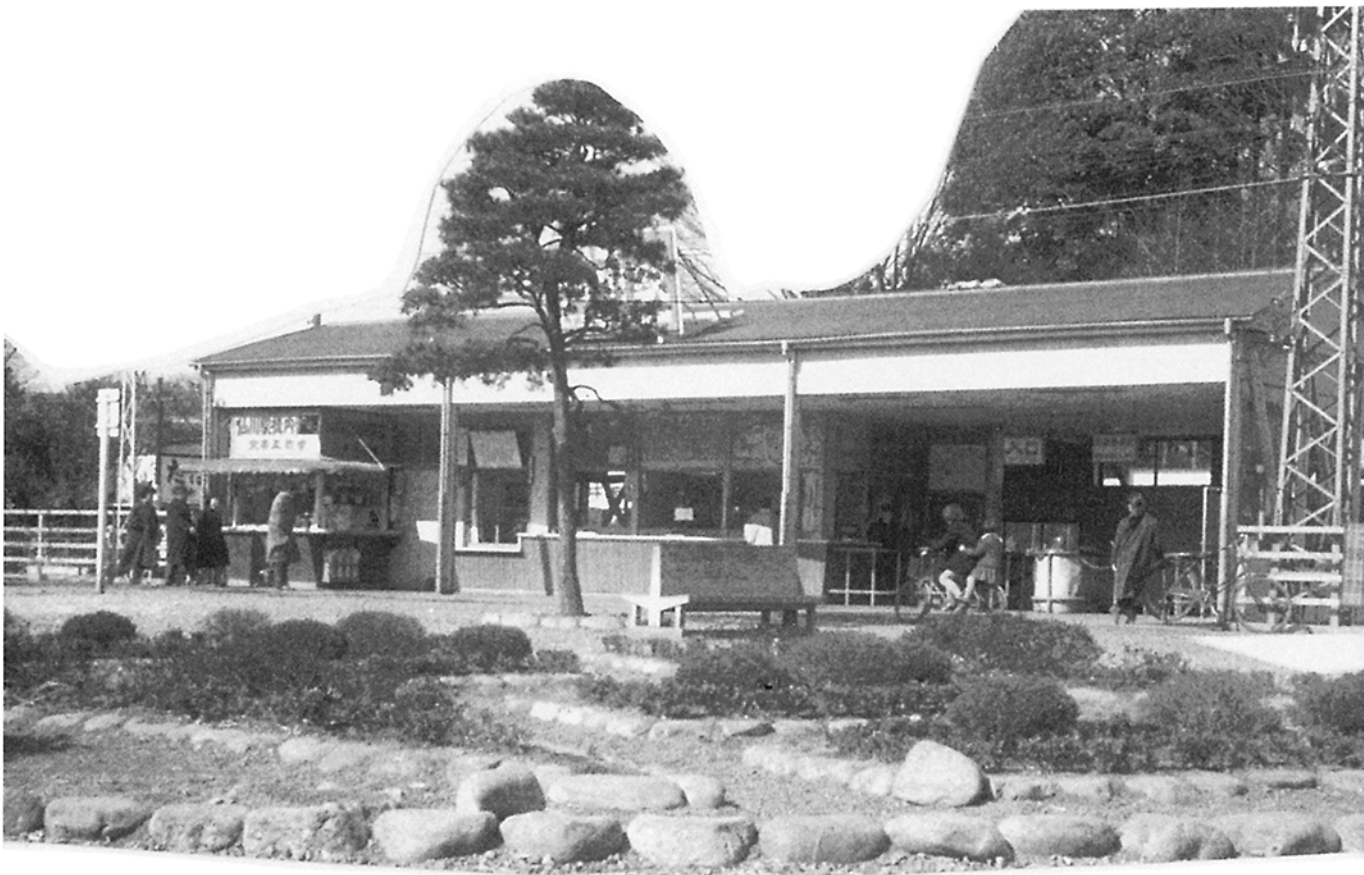
改築した仙川駅舎と広場 58(昭33)年2月
