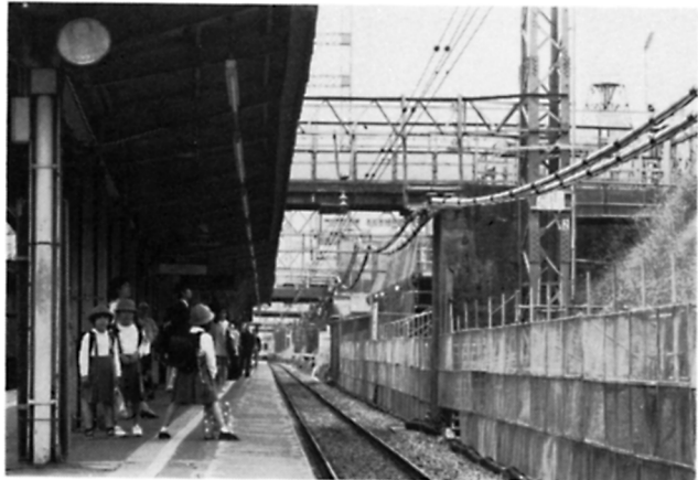
仙川駅にもう一つのホームが増設工事中
